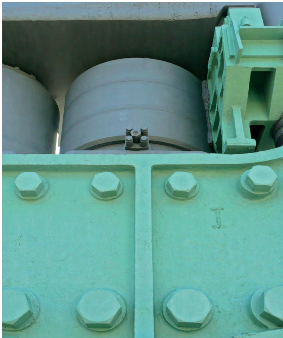
Fig. 28 - Particolare dei cilindri con gli attacchi per le tubazioni dell'acqua in pressione.
