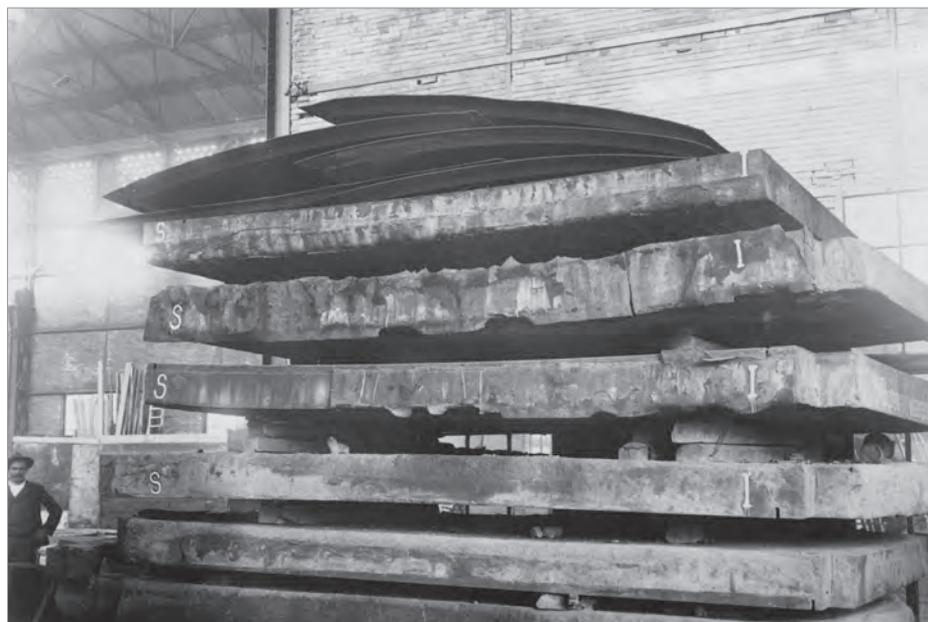
Fig. 15 - Il fusto di un cannone navale dopo la forgiatura alla pressa e inviato al reparto lavorazioni meccaniche per la finitura.
