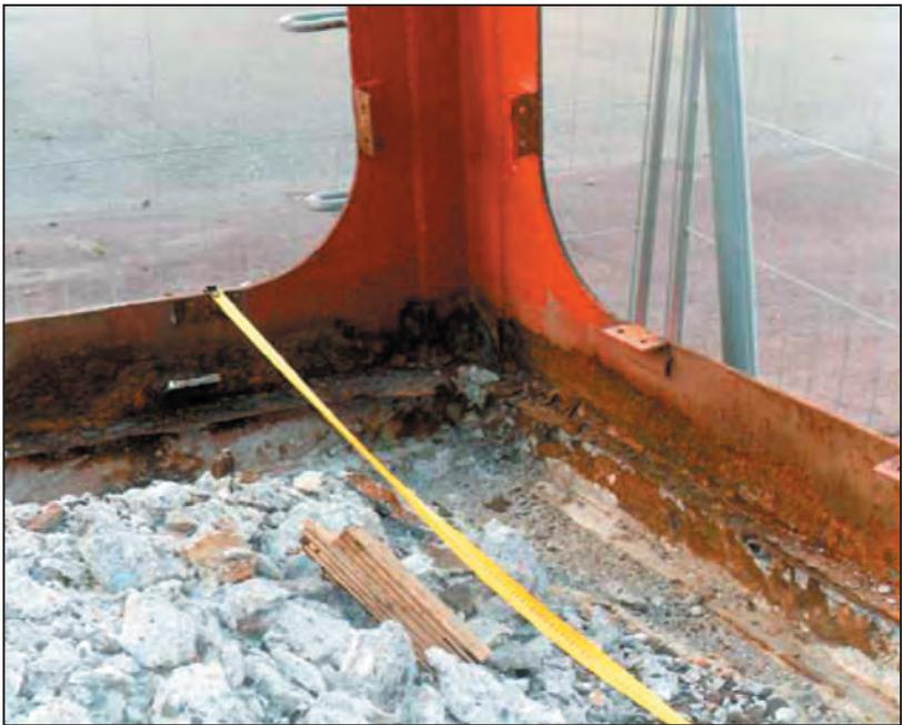
Fig. 19 - Esterno del basamento, prima del restauro. Fig. 20 - Interno del basamento, dopo la demolizione del blocco fondale in calcestruzzo. Si nota lo stato di degrado.
