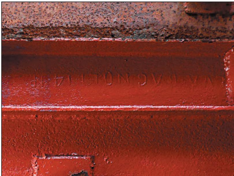
Fig. 11 - Particolare delle putrelle di coronamento con la scritta, a rovescio, ILVA BAGNOLI 14 NP
