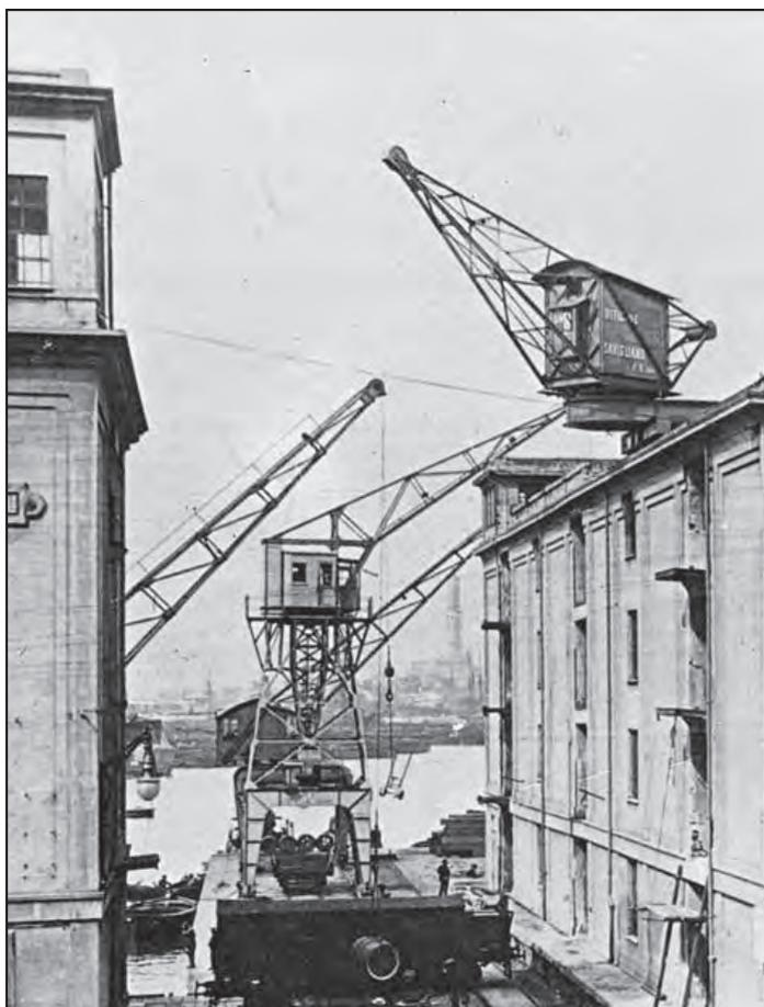
Fig. 6 - Ponte Morosini, inizio Novecento. Particolare con gru elettriche.
