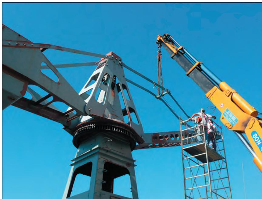
Fig. 17 e 18 - La gru durante i primi interventi di pulizia e smontaggio. Notare la tipologia della gru e del cestello di servizio, con funzionamento oleodinamico.
